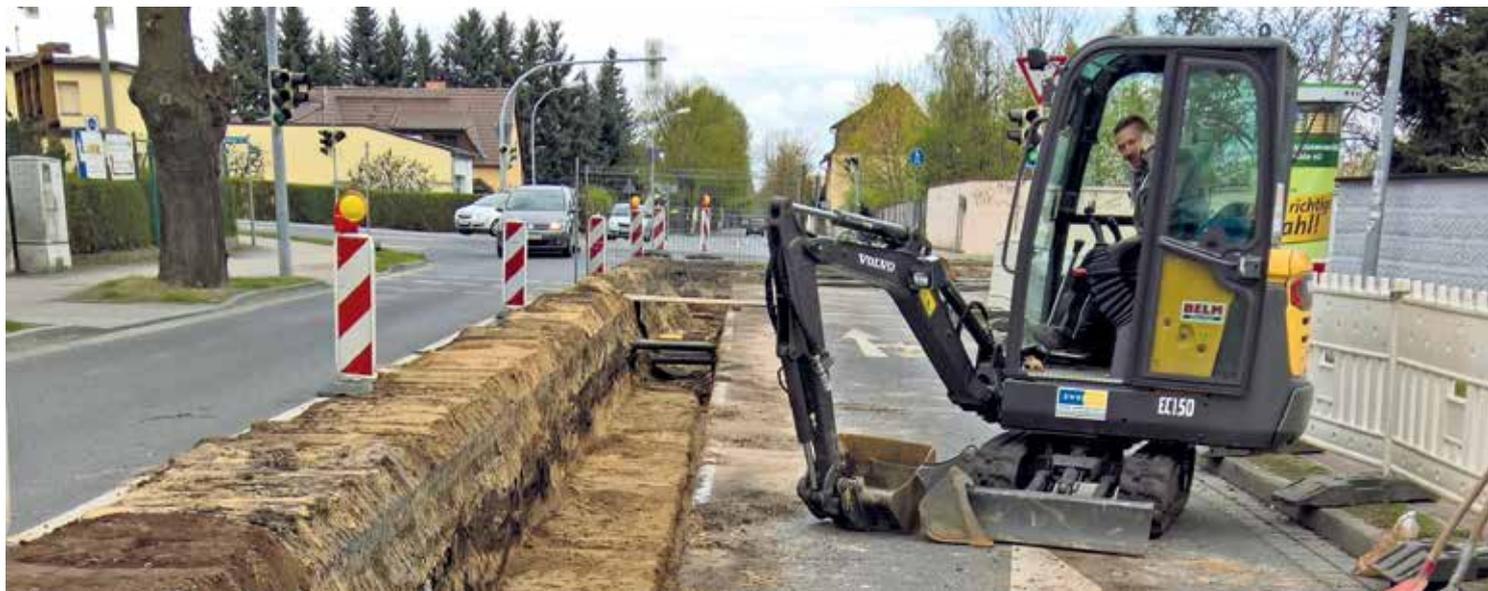
*Für die neue Fernwärmetrasse sind umfangreiche Tiefbauarbeiten erforderlich*
