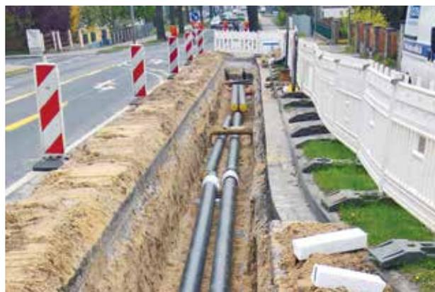
*Auf einer Strecke von rund 950 m wird ein Kunststoffmantelrohr verlegt*
